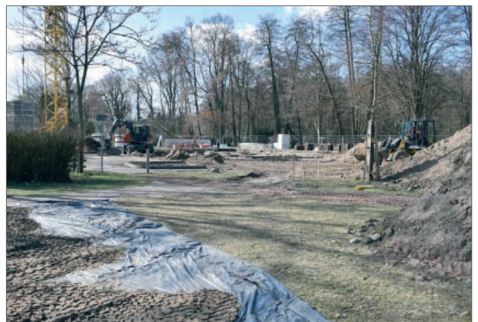
● Der erste Aushub für das Streifenfundament: Das Gelände am Mühlenteich am 17. März. Foto: K. Brandau
